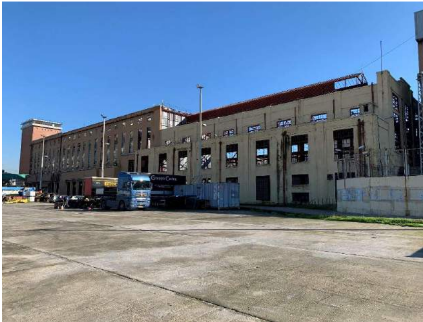
Εικ. 16. ΑΗΣ Αγ. Γεωργίου. ΒΔ όψη του σταθμού σήμερα. Πηγή: Προσωπικό αρχείο.
