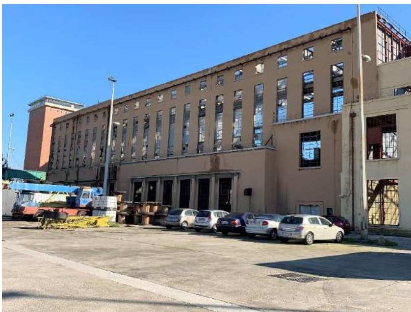
Εικ. 18. ΑΗΣ Αγ. Γεωργίου. ΒΔ όψη του Κτηρίου Δ σήμερα. Πηγή: Προσωπικό αρχείο.
