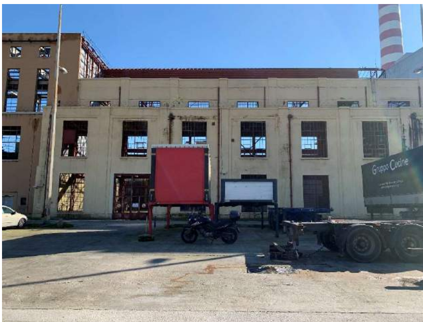
Εικ. 17. ΑΗΣ Αγ. Γεωργίου. ΒΔ όψη του Κτηρίου Α σήμερα. Πηγή: Προσωπικό αρχείο.
