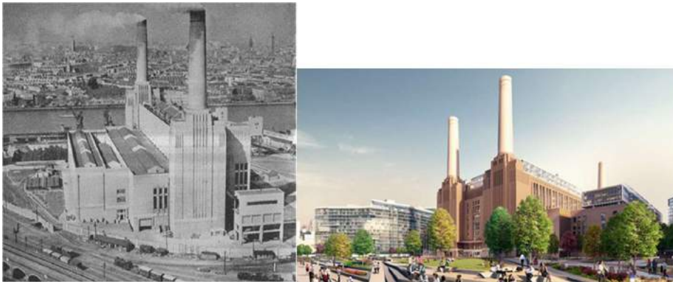
Εικ. 12,13. Battersea power station. Τότε και τώρα. Πηγή: Wikipedia και https://www.macegroup.com/projects/battersea-power-station
